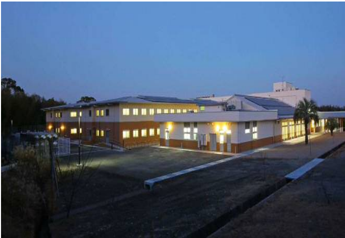
全景写真 (上) 環境に配慮して太陽光パネルを設置！ (下) 夜の状況
