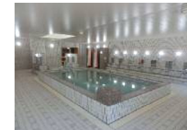
浴室 60人・45人の浴室を設置
