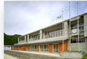
改修後の職員室外観
