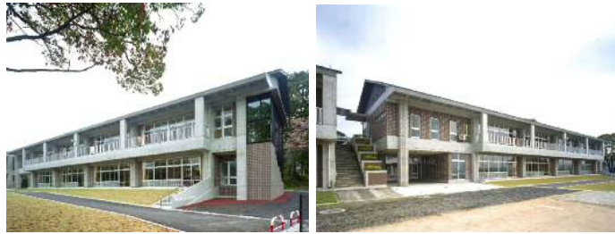
東棟校舎 南東面
