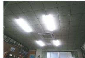
非構造部材の照明器具は取付金物を補強し刷新
