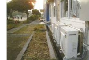
転倒防止基礎設置により整然と並び室外機
