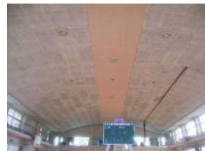
撤去前の天井
