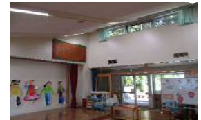
勾配天井とハイサイドライト により開放的な空間
