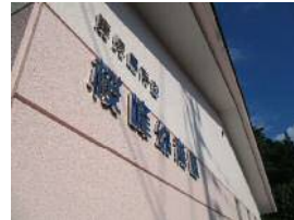
幼稚園らしい明るい外壁
