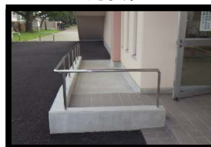
玄関にはスロープを付けま した
