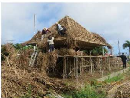
農作業準備休憩施設(高倉)の葺き替え作業
