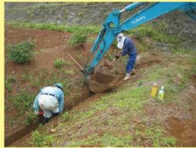
排水路や沈砂池の泥上げ
