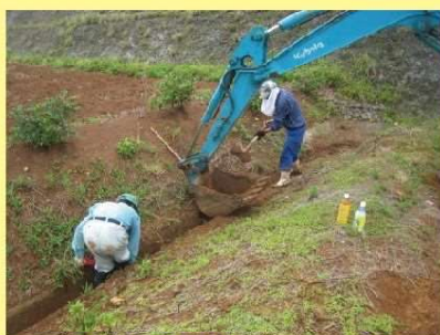
排水路や沈砂池の泥上げ
