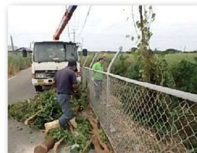
沈砂池の堆積物の除去
