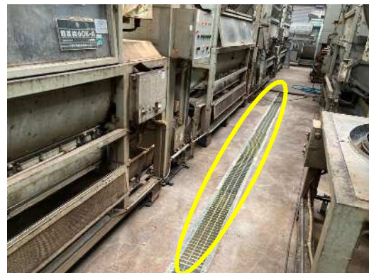
工場内排水溝整備で衛生環境改善
