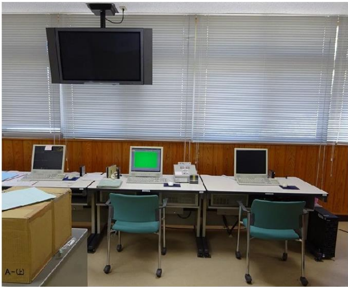
ダム管理所 操作室
