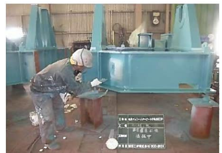
塗装による機械設備の補修
