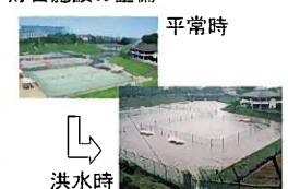
貯留施設の整備
