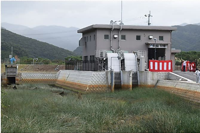
石原排水機場の整備
