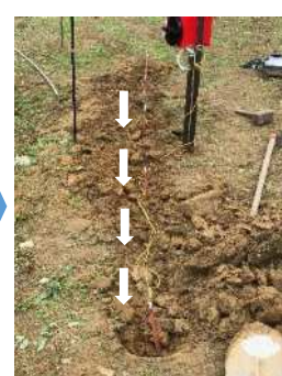
間隔をあけて、地中にしっかりと打ち込む(良い例)
