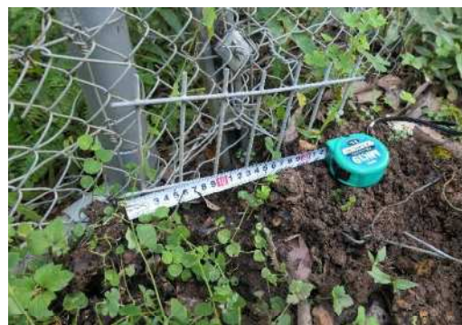
地際の隙間に金網を追加設置
