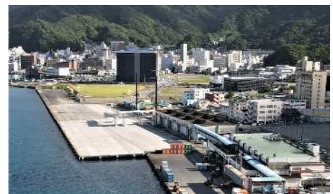
名瀬港本港地区2号岸壁
