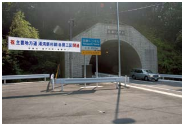
湯湾新村線「赤房工区」開通 (役勝トンネル開通) (奄美市・7月)
