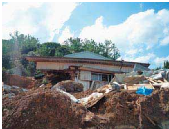
裏山が崩れ家屋が全壊 (龍郷町 浦)
