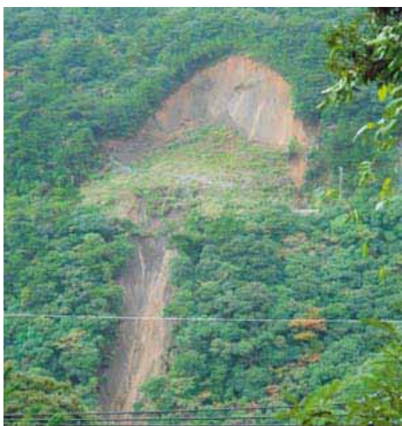
山裾が崩れ, 土砂が道路を覆った (瀬戸内町 網野子 国道58号)
