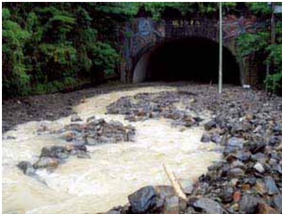
トンネル内に土砂が流れ込み、通行が遮断 (奄美市 住用町 国道58号 城トンネル 21日 9時)
