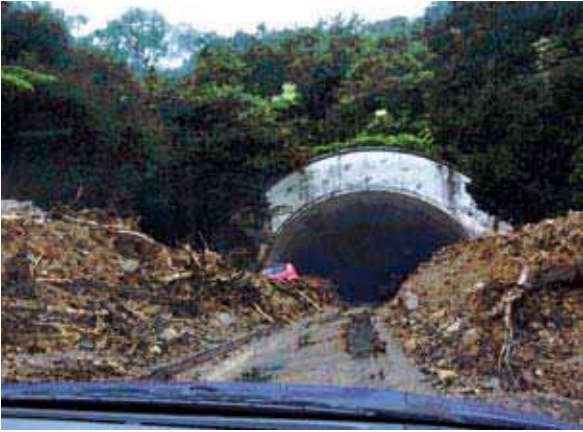
ふさいでいた土砂をかき出し車1台分の車道を通した (大和村 毛陣トンネル)
