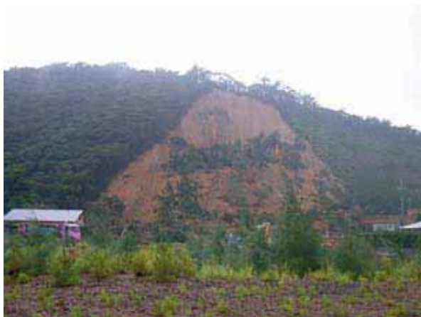
山が崩落し, 国道を遮断 (龍郷町 浦 国道58号)
