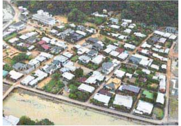
集落全体が冠水 (大和村 大和浜 23日)
