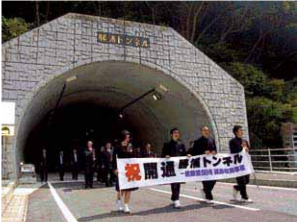
勝浦トンネル開通式 (瀬戸内町・3月)
