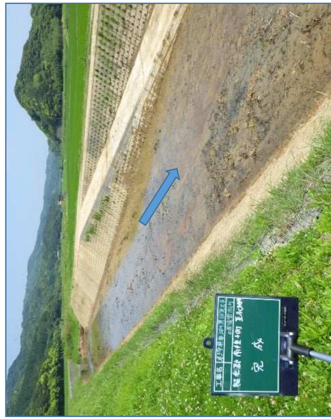
宮瀬川（着工後）
