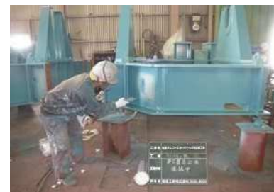
塗装による機械設備の補修
