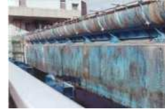
水門(ゲート塗装の劣化)
