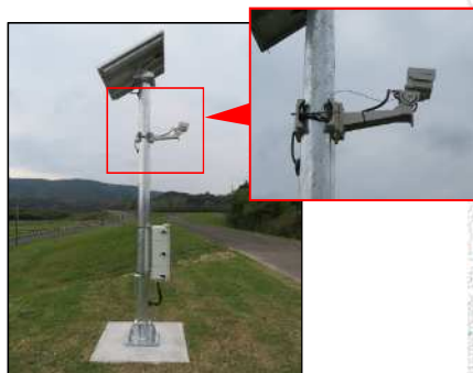
簡易型河川監視カメラ
