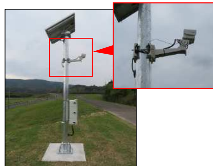
簡易型河川監視カメラ
