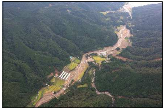
平成28年台風16号による串良川災害
