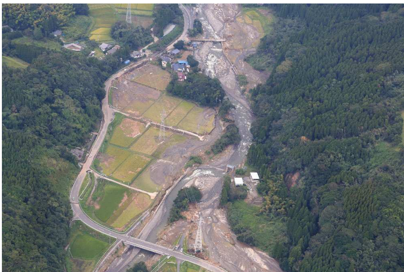
平成 28 年 台風 16 号による本城川（垂水市）の浸水被害
