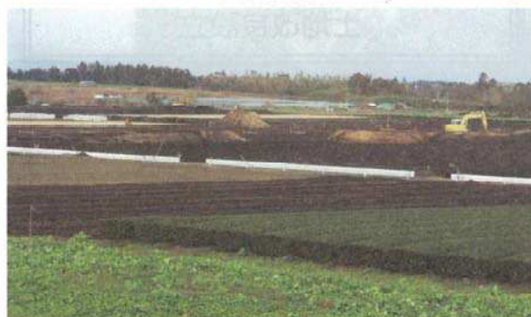
第一吾平地区工事実施状況
