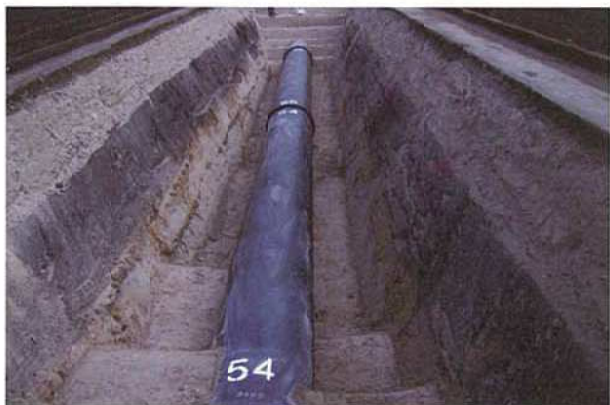
パイプライン埋設状況
