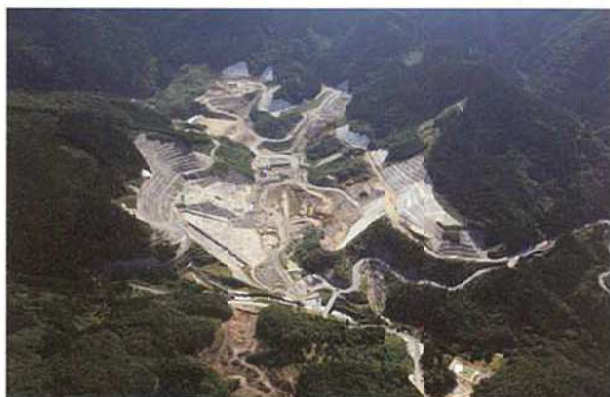
荒瀬ダム施工状況（平成21年10月撮影）
