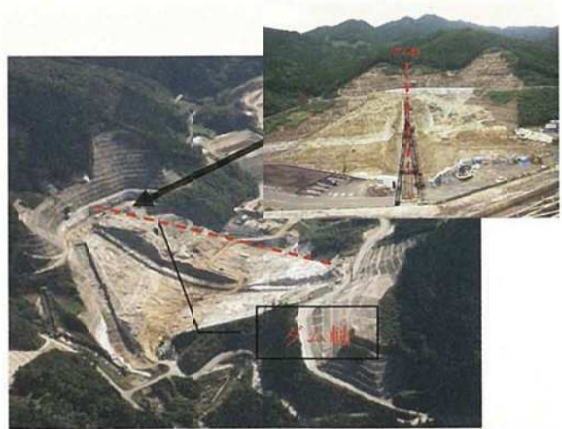
荒瀬ダム航空写真 (H22.11)
