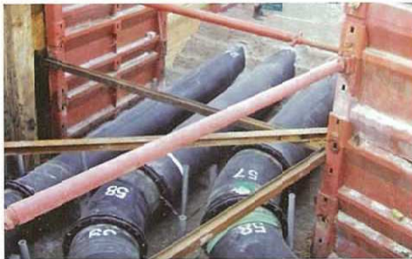
支線水路（角野工区）工事 （鹿屋市吾平町上名）
