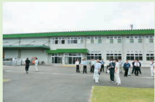
冷凍加工処理施設
