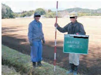
設置位置立会（確認）
