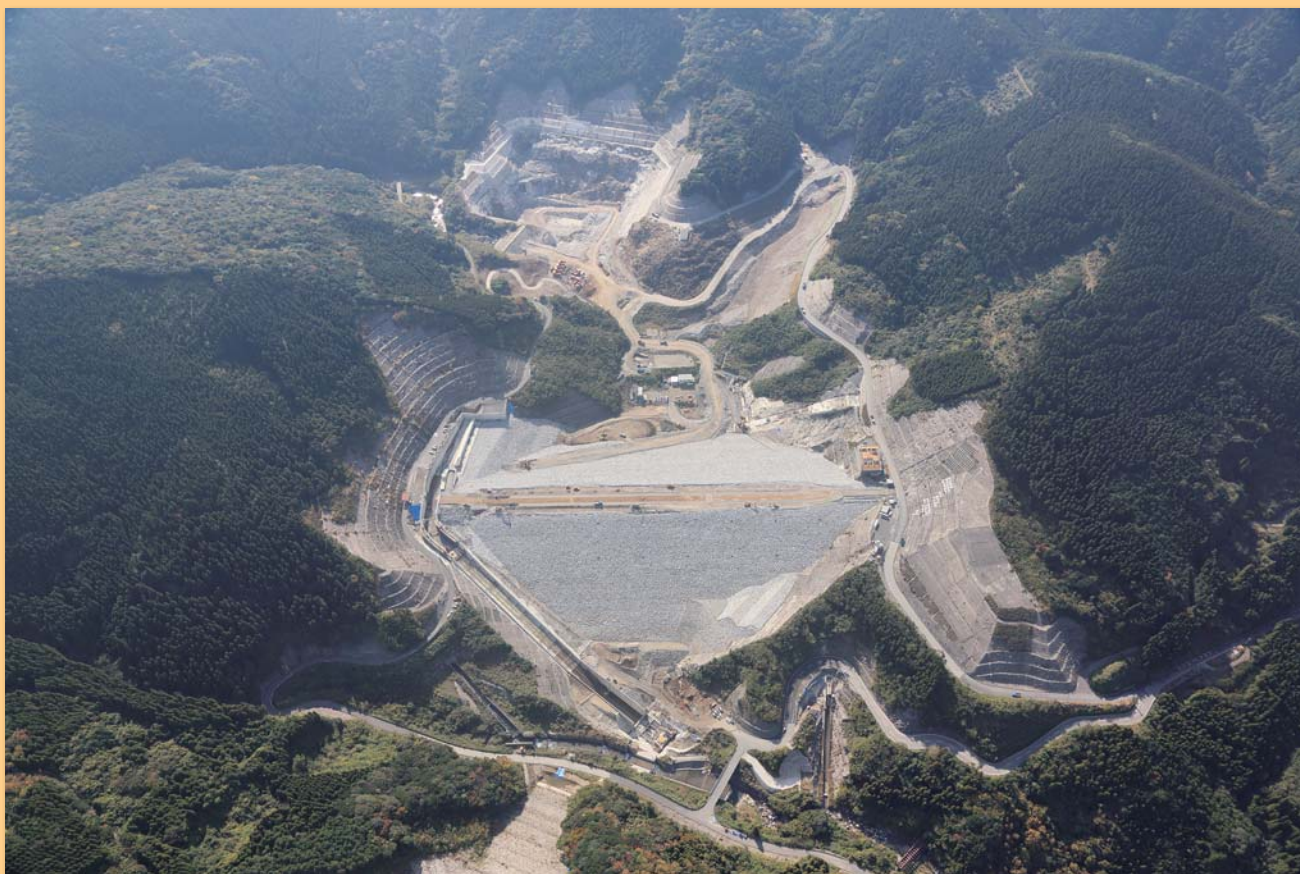
荒瀬ダム(国営事業)の工事進捗状況(平成25年11月現在)
