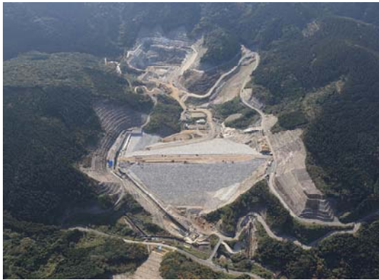
写真1 荒瀬ダム（施工中）
