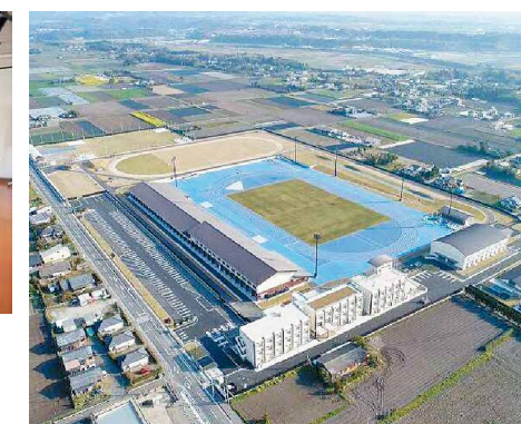
ジャパンアスリートトレーニングセンター大隅
