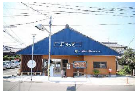
空き家改修の例（錦江町）
