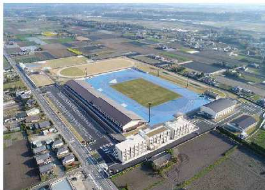
ジャパンアスリート トレーニングセンター大隅
