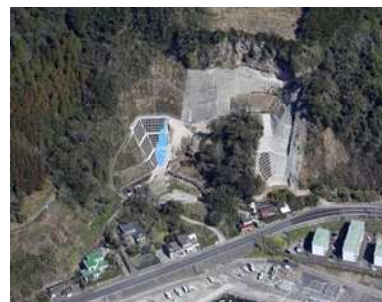
急傾斜地崩壊対策事業
