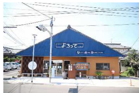
空き家改修の例（錦江町）
