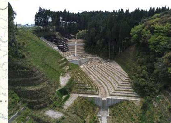
山地災害の復旧(完成) 溪間・山腹工
