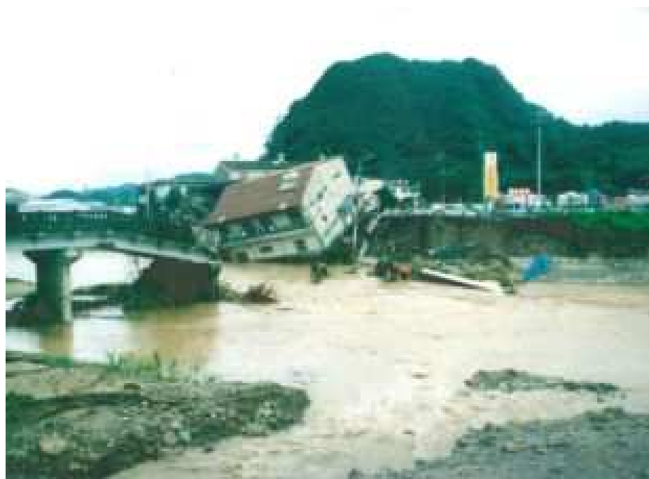
平成5年8月1日の集中豪雨 思川 城瀬橋
