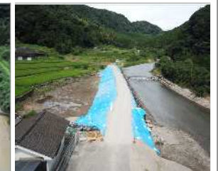
R7. 8. 29 応急工事完了
