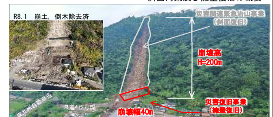
斜面対策及び擁壁復旧の概要
