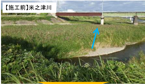
【施工後】米之津川
