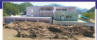
平成28年台風10号により、岩手県の要配慮者利用施設では利用者9名の全員が死亡。
