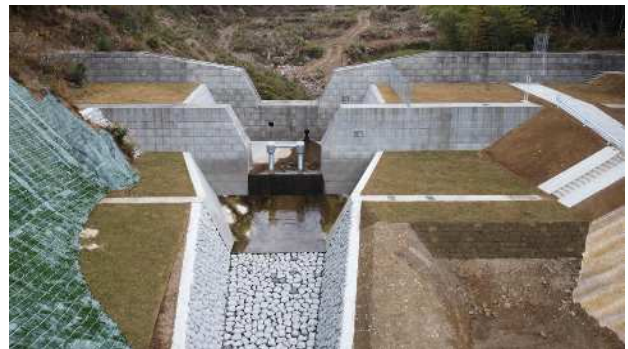
砂防えん堤（さつま町 大畝川）
