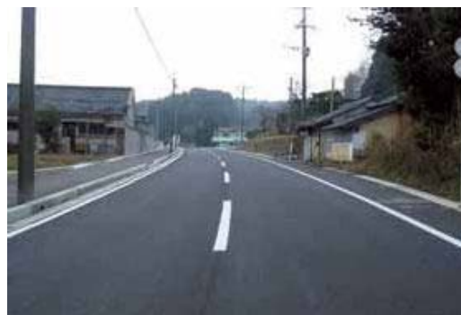
完成：鶴田停車場線（鶴田工区）
