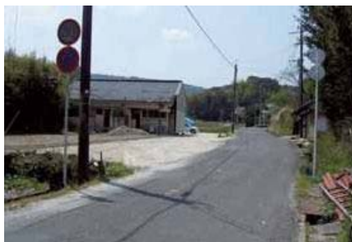
着工前：鶴田停車場線（鶴田工区）
