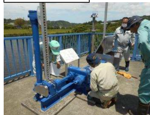
樋門操作講習会
