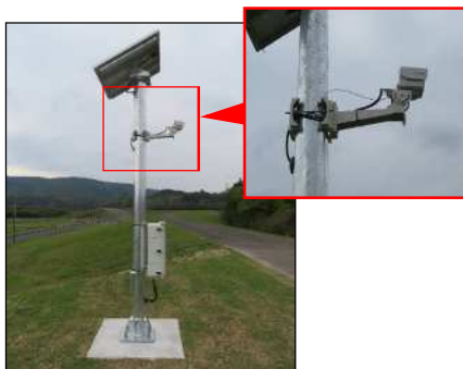
簡易型河川監視カメラ
