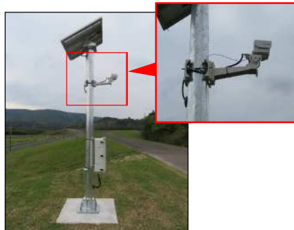
簡易型河川監視カメラ
