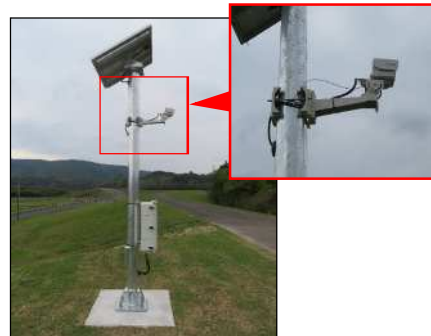
簡易型河川監視カメラ
