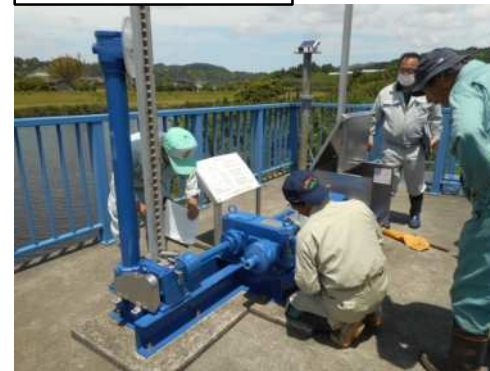
樋門操作講習会
