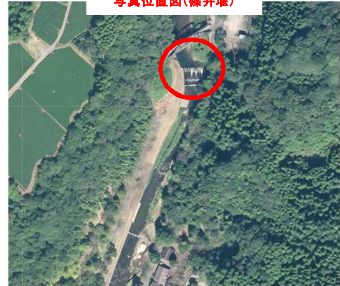
現況写真(篠井堰)
