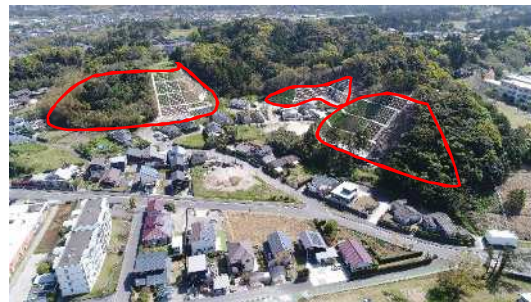
急傾斜地崩壊対策事業(平之馬場地区)
