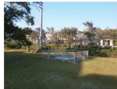
設置予定箇所
