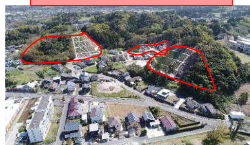
急傾斜地崩壊対策事業 南薩局管内事例(南さつま市平之馬場)
