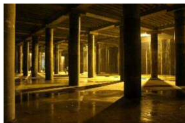
大規模地下貯留施設(下水道)
