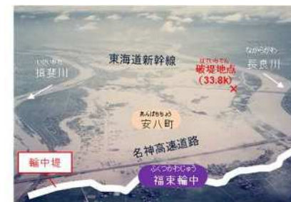
岐阜県輪之内町（福東輪中）
