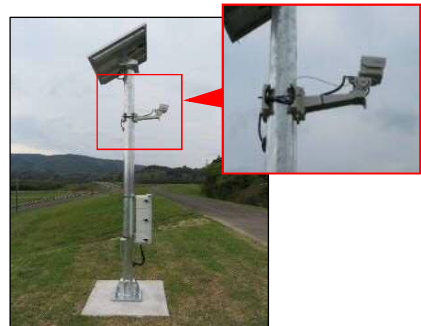
簡易型河川監視カメラ
