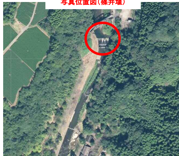
現況写真(篠井堰)
